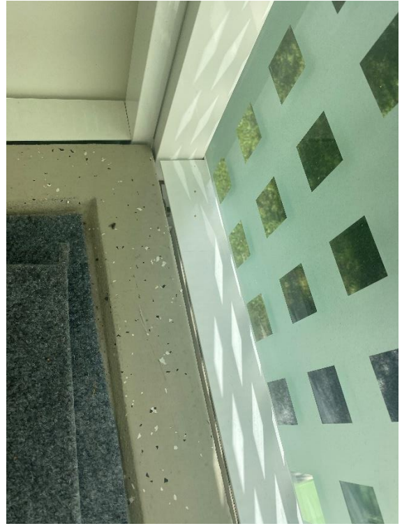
Kuva 5 Lasituksien ja parvekkeiden lattiaelementtien väliin jää huomattava rako
