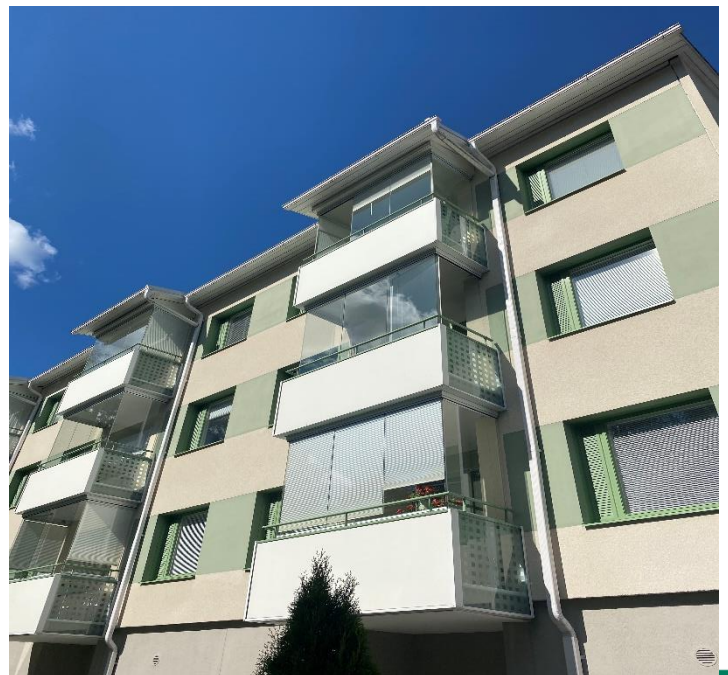
Kuva 2 Yhtiön parvekkeet ovat toteutettu elementeillä.
